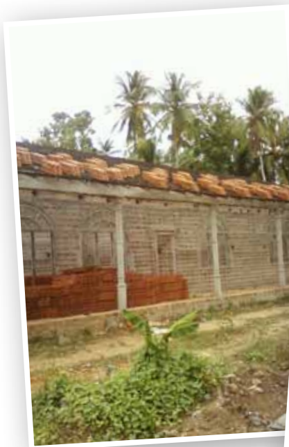
Het nieuwe weeshuis in Katupota in aanbouw.
